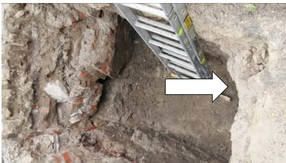
Fot. 14: Platan klonolistny ( Platanus xhispanica ); trzy odkrywki poszukiwawcze. Resztki fundamentu Komendy Garnizonu Bydgoskiego. Brak korzeni. Strzałka wskazuje na drzewo odl. ok. 15 m. 9.06.2019. Bydgoszcz, ul. Karmelicka. Fot. Zleceniodawca
