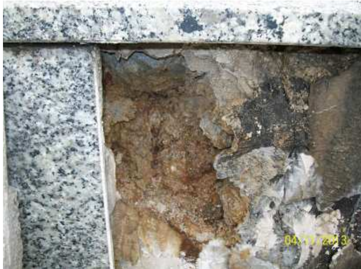
Fot.8. Pokryte korozją pręty zbrojeniowe.
