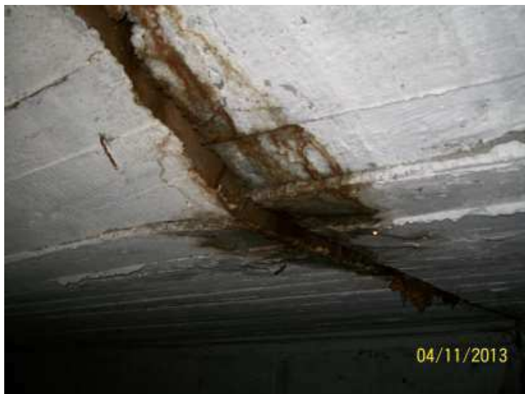
Fot.11. Dolny fragment dylatacji środkowej.
