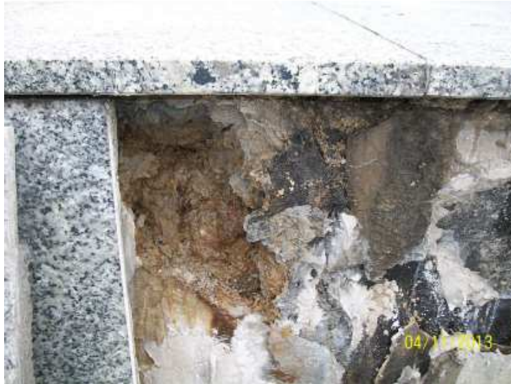
Fot.6. Fragment izolacji bitumicznej pod warstwą kleju.
